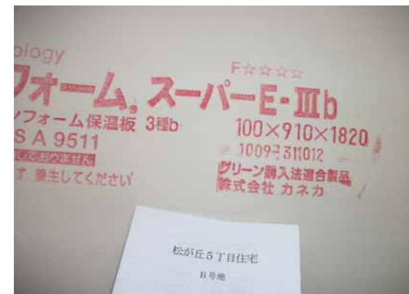
2階ハネ出部床断熱材
