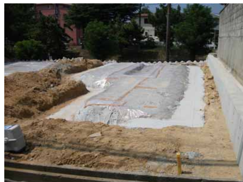
捨コン防湿シート状況
