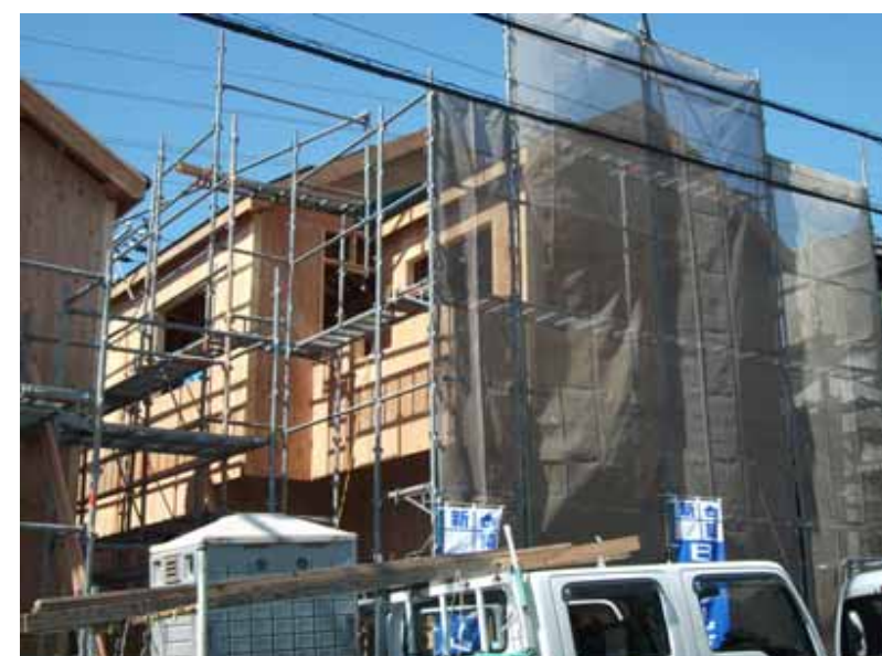
外壁合板張工程
