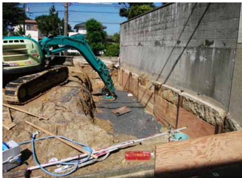
擁壁工事掘削状況
