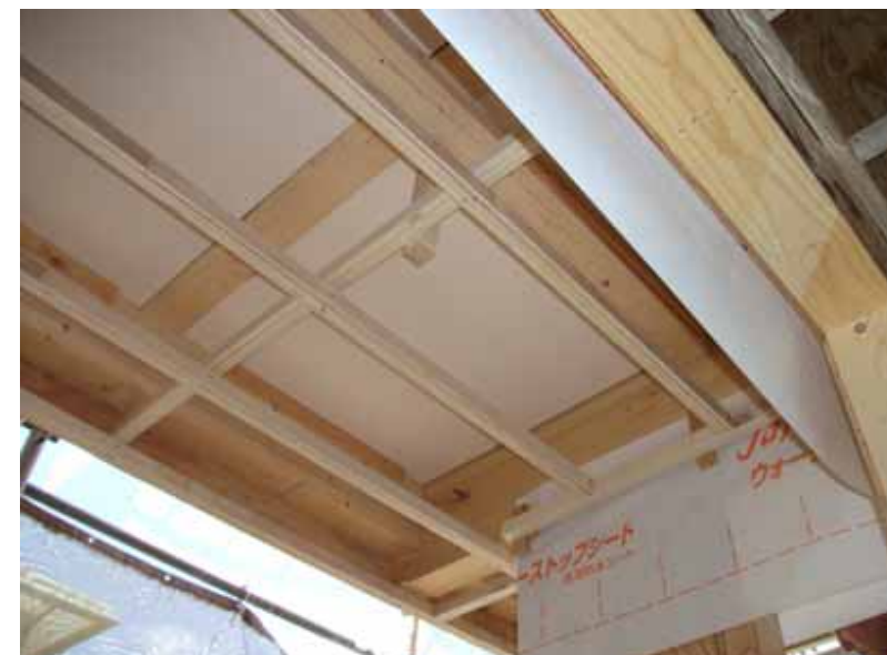
ハネ出床断熱状況
