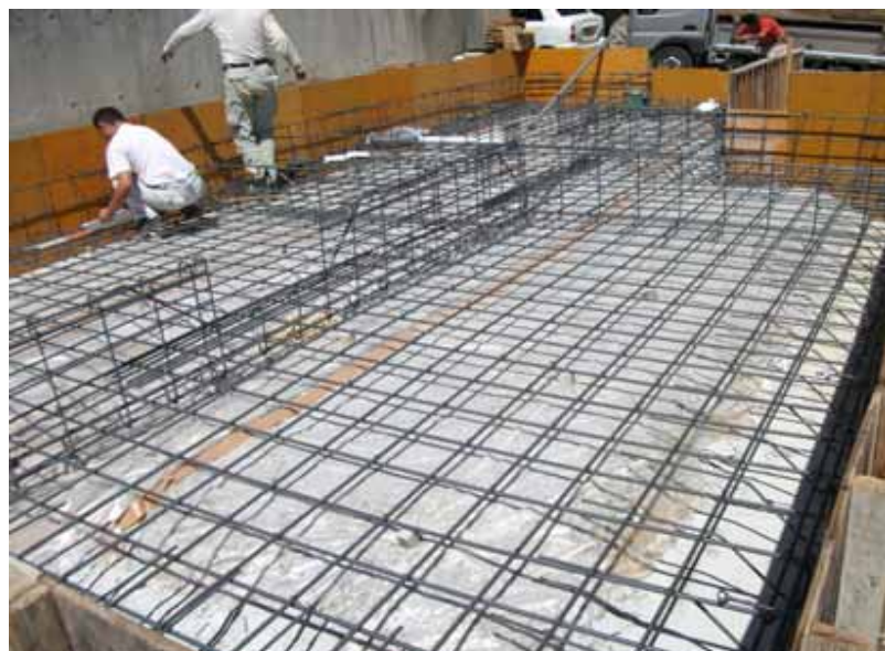
ベタ基礎部配筋状況
