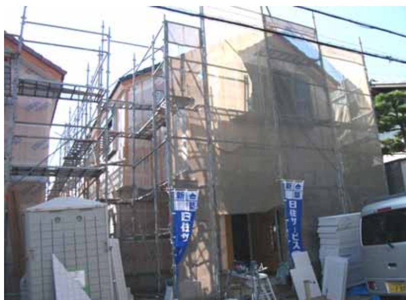
パワーボード張工程
