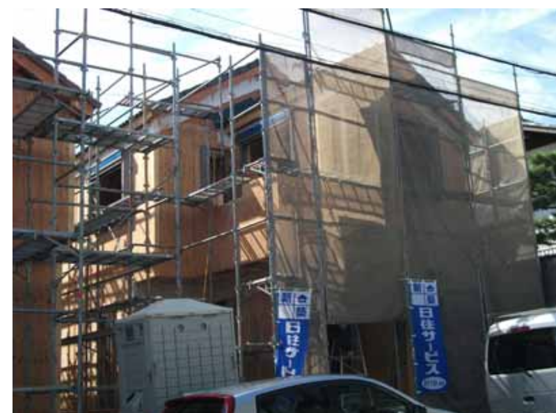
合板張屋根葺完了
