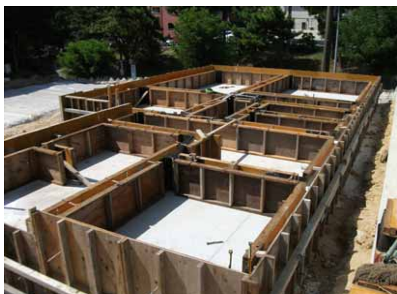
立上部コンクリート打完了
